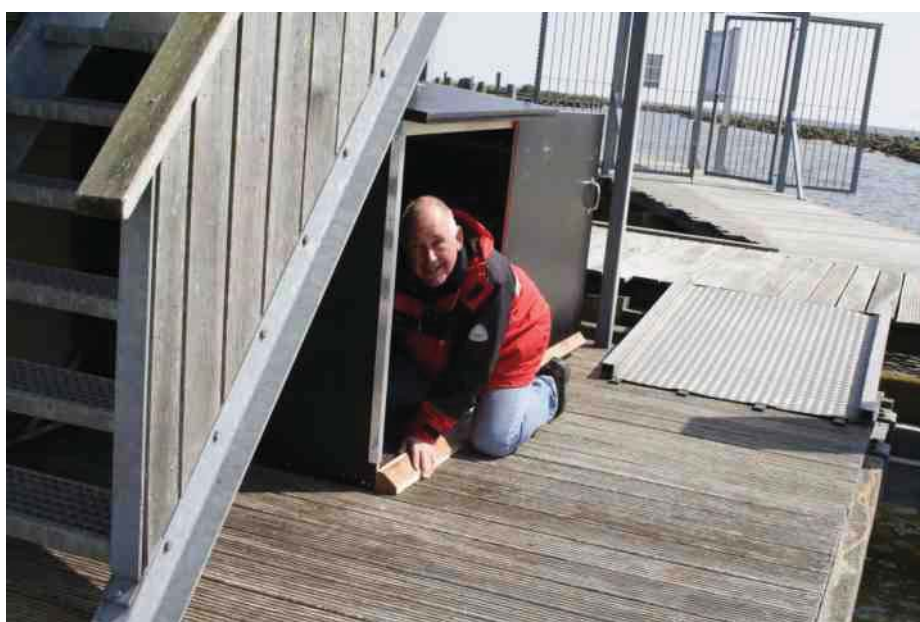
Montage van de parkeergarage op het eiland
