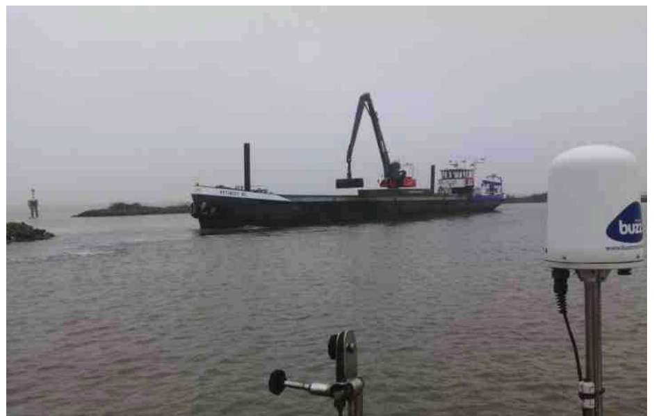
Na drie dagen baggeren is de Kreupeilandhaven weer op diepte.
